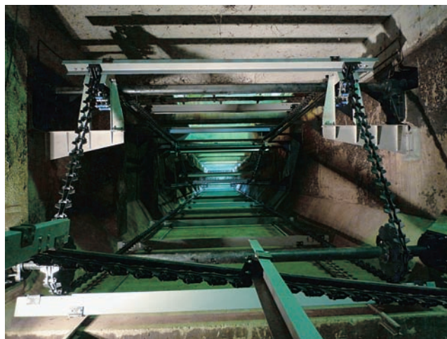
ノッチチェーン式汚泥掻き寄せ機
