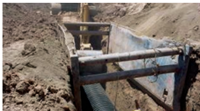
写-2 Mexicali下水管路敷設工事—HDPE 1000mm
