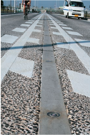
道路に散水装置を設置してヒートアイランド対策の実験も
