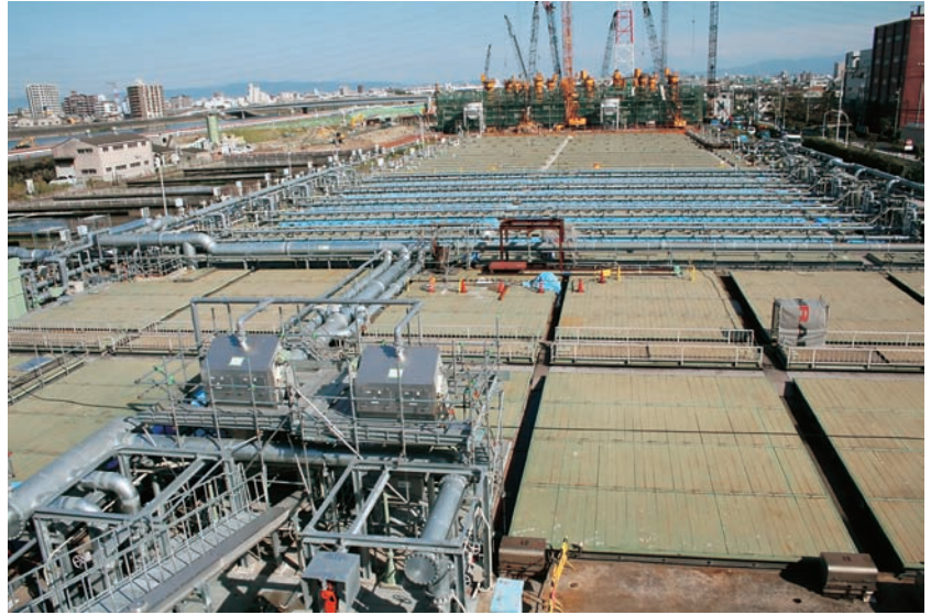
既存の水処理施設を改造しMBRを導入（中央のパイプが見える部分）。その奥には工事中の大和川ポンプ場が見える
