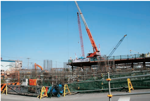
平成25年度の完成をめざす新2系水処理施設
