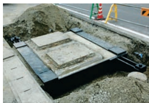
出雲崎町(アンカーウイング工法)
