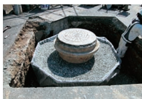
浜松市(マンホールフランジ工法)
