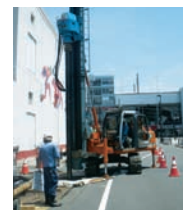
横浜市(アンカーウイング工法)
