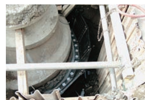
横浜市(マンホールフランジ工法)
