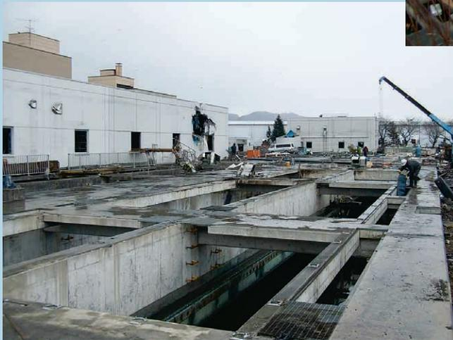
被災した最終沈殿地（大船渡浄化センター）
