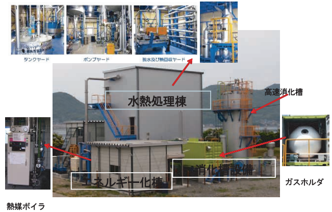
写真-3 実証プラント外観
