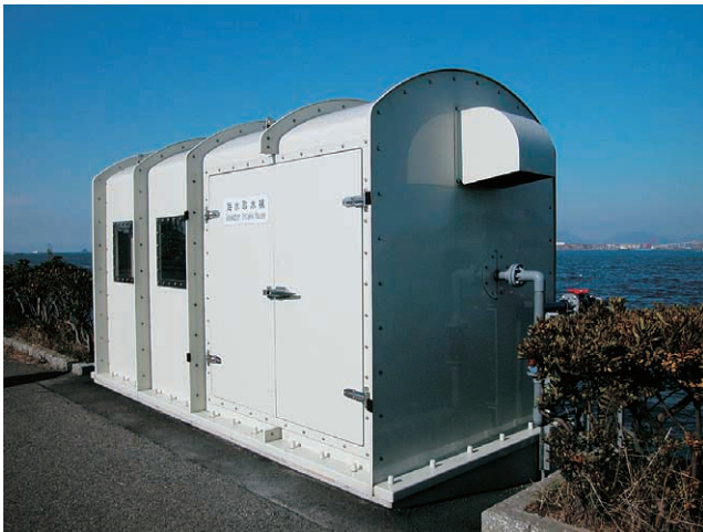
浄化センターの関門海峡側につくられた海水取水棟
