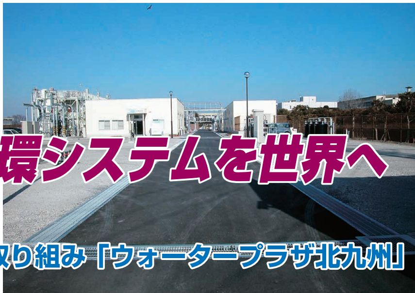
日明浄化センターに建設されたウォータープラザ
