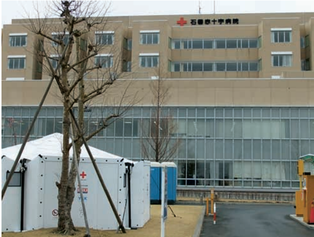
石巻赤十字病院外観 (石巻赤十字病院)
