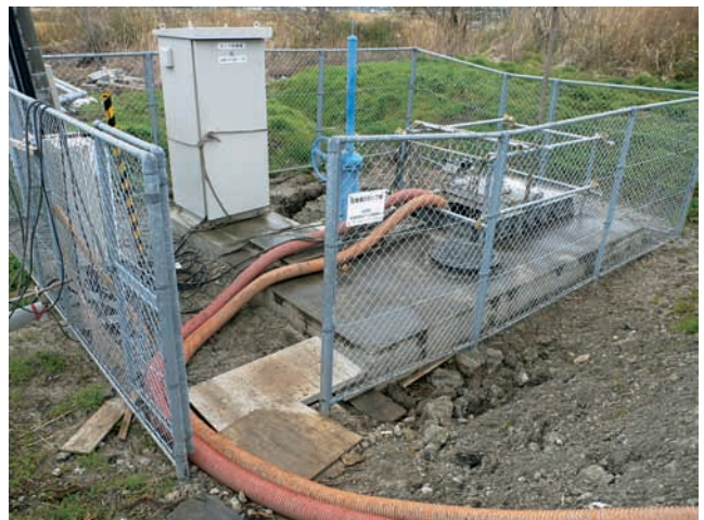
仮設ポンプ設置状況 (石巻第二汚水中継ポンプ場)
