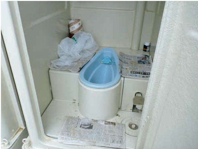
災害用仮設トイレ内（気仙沼小学校） （詰り防止のため紙は分別回収）
