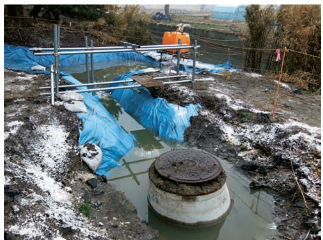
上流マンホール位置での沈殿+消毒放流 (八戸汚水中継ポンプ場)
