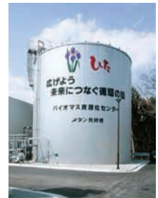
写真-2 銅板製消化タンクの例
