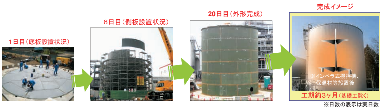
実証実験施設の建設状況
