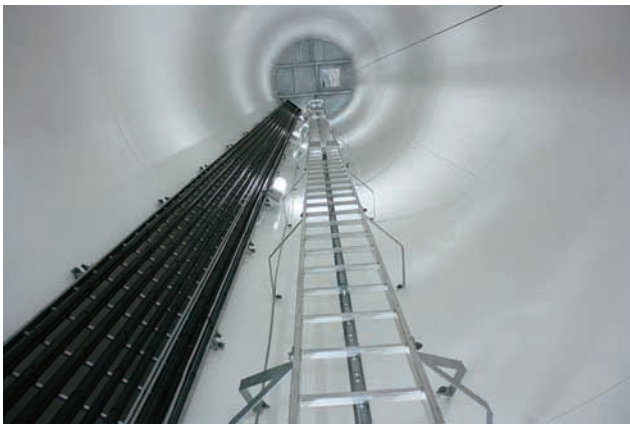
風車内部にはコードが走る
