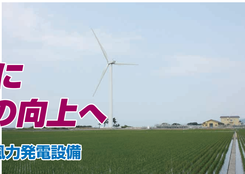
町のシンボルともなっている浄化センターの風車
