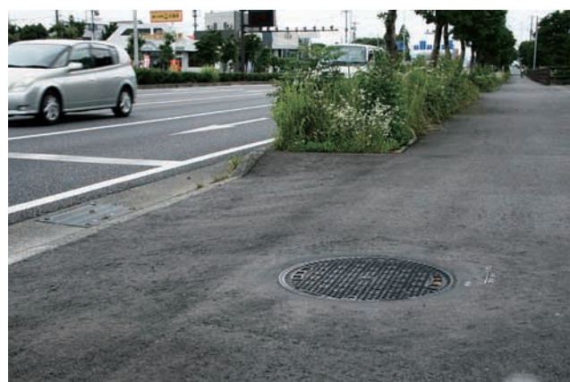
歩道での設置状況
