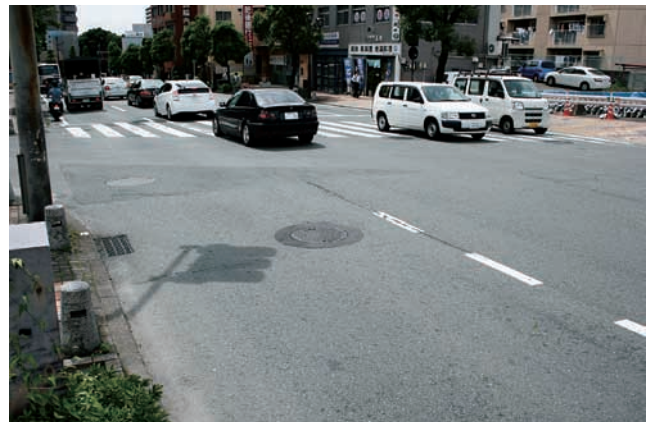
取替工事によって車道に設置された次世代型マンホールふた
