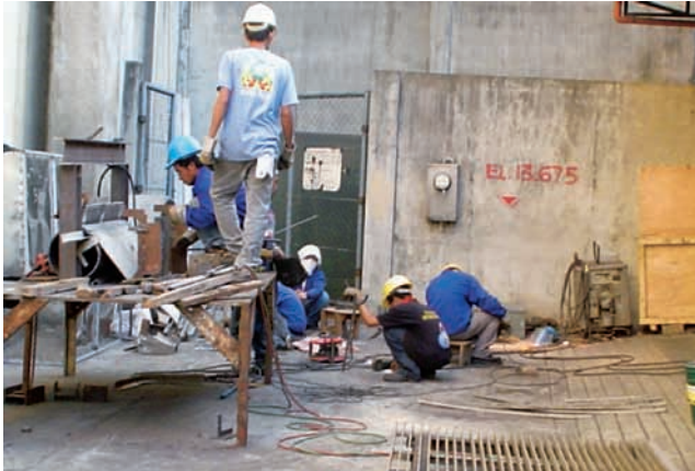
格子スクリーン組立設置工事（マニラ）
