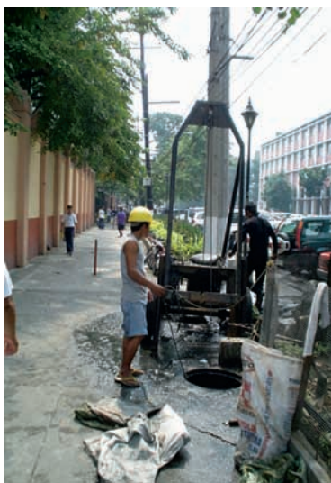
管路内堆積物除去作業（マニラ）
