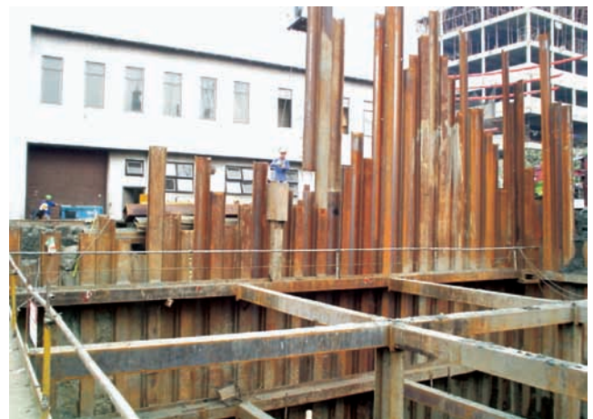
トンドポンプ場沈砂池仮設工事（マニラ）
