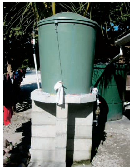
均等配水方式の個別受水槽（キリバス）
