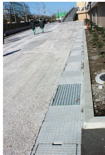
施設内の保水性舗装（左側）。通常のアスファルトと比べて温度も低い
