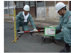
被災地での管路調査（岩手県）
