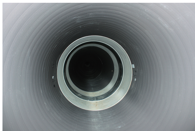
美しく仕上がった内部
