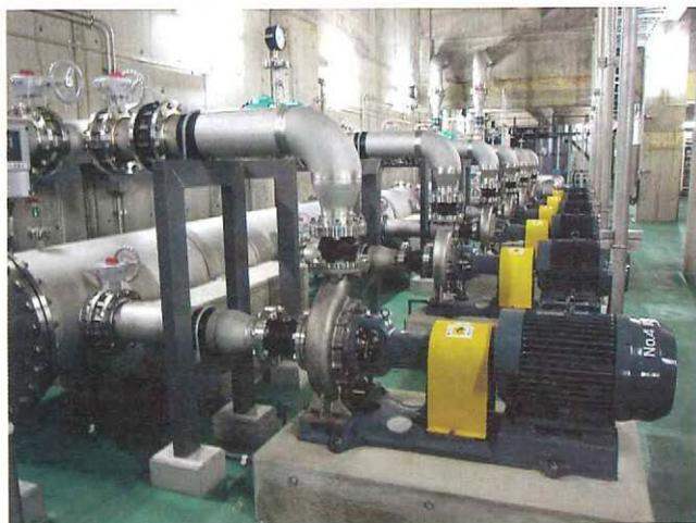
圧送ポンプは45kWのものを全部で6基設置
