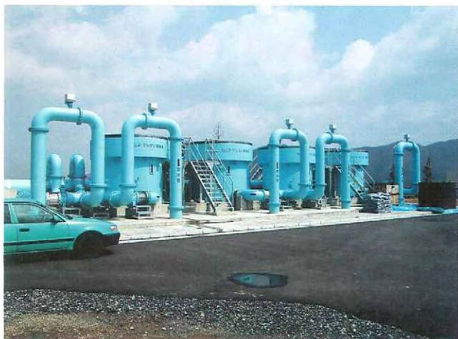
水に溶けたマンガンを析出させるためのマンガン接触塔
