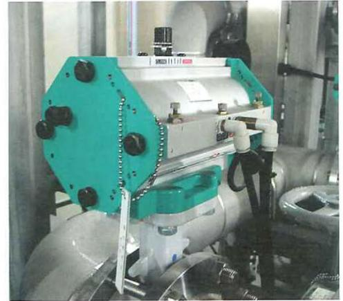
結露を考慮して電気式ではなく空気圧式のパルプを採用している
