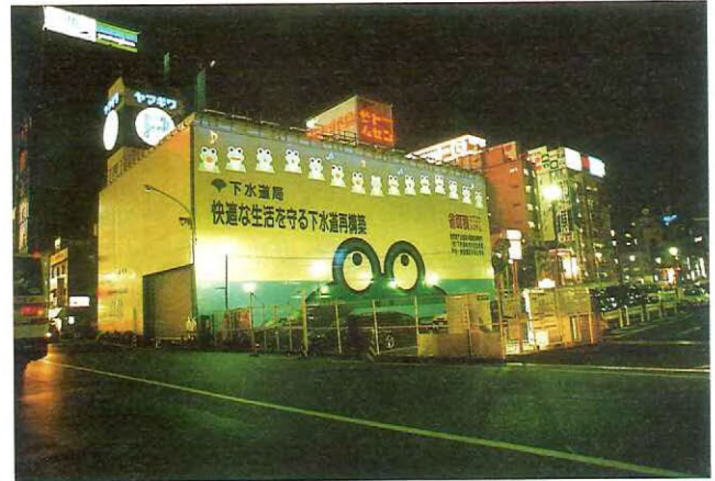
省面積立坑システムが初めて採用された秋葉原の現場
