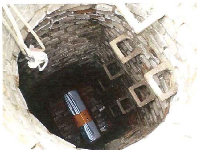
中間マンホールから見たライナーの状況。オレンジ色の部分からテストピースを採取。
