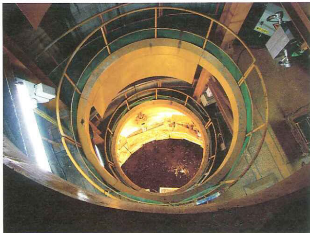
スカフォード（足場）から東立坑の掘削現場を見る
