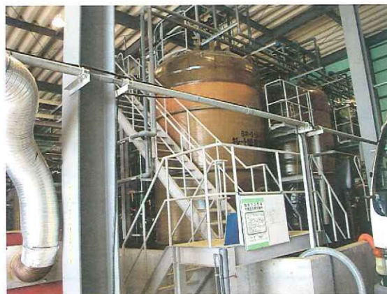
施設内から出る排水に含まれるホウ素を除去するためのキレート吸着塔
