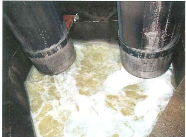
直接流出のため、すぐ下には池になるような構造にしてある
