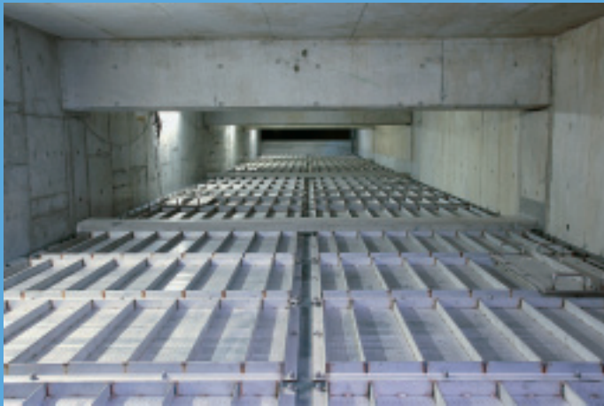
ろ過池の上部スクリーン。この下にろ材が入っている
