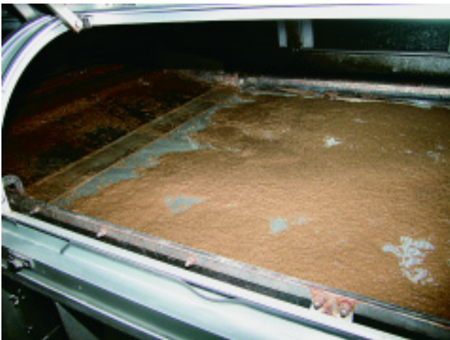
投入された汚泥がみるみるろ過されていく
