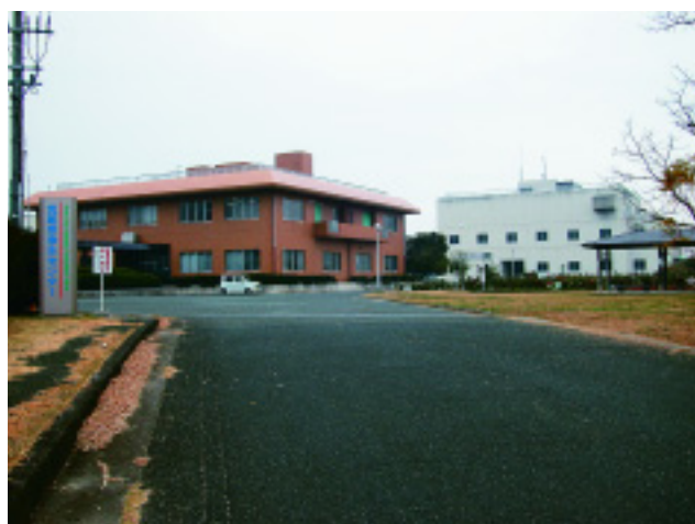
ベルト型ろ過濃縮機が導入された荒尾市浄水センター
