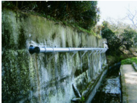
写-1 完成した露出配管 (熊本県益城町)
