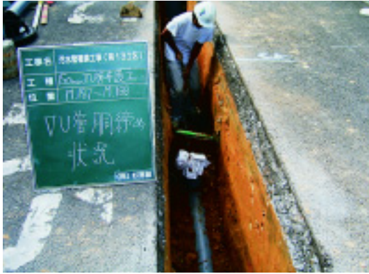
写一 4 発生土の管きょ基礎への利用 (愛知県半田市)
