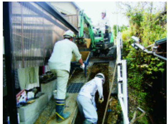
写-3 地表勾配に沿った管きょ施工箇所 急傾斜地道路 (愛知県半田市)
