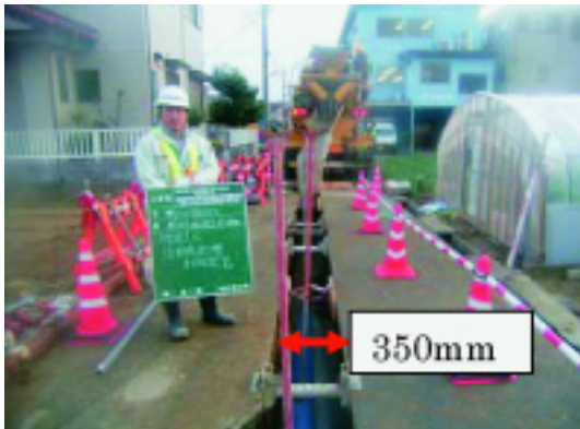
写一 5 流動化処理土施工箇所 (静岡県浜松市)
