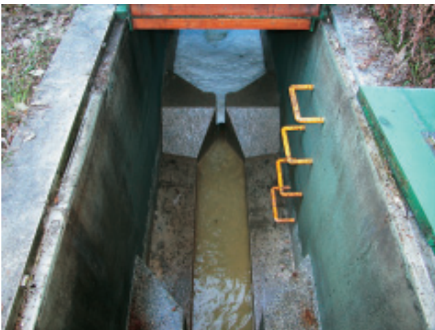
減勢された下水はゆっくりとした流れになって下流へ
