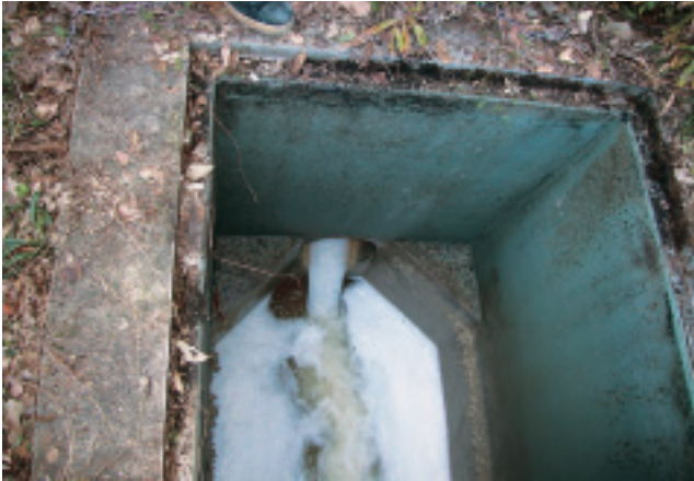
勢いよく減勢装置に流れ込む下水
