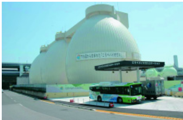
「こうべバイオガス」施設
