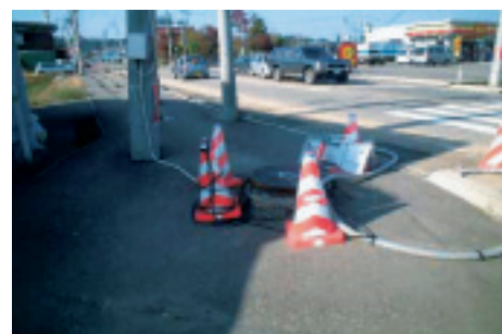
汚水の溢水対策として仮配管、仮排水ポンプによる応急復旧状態
