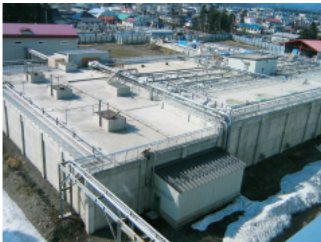
廃水処理施設の全景
