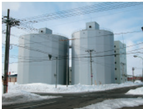
澱粉製品は粉体輸送で近くにある巨大なサイロへと送られる
