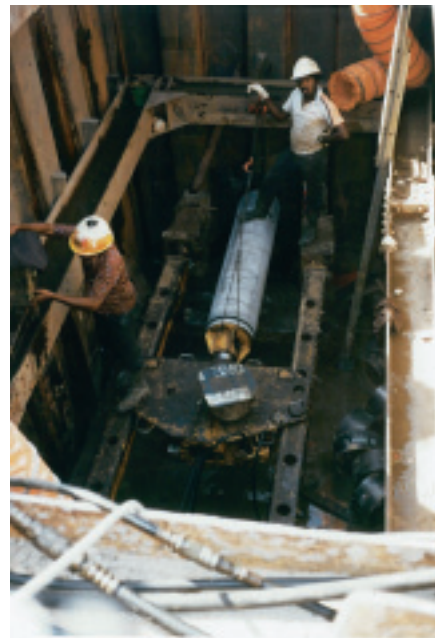
マレーシア バターワース アイアンモール工法による推進（1983年）
