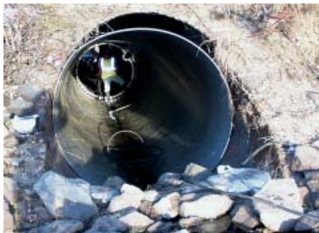
高速道路下横断管施工（施工中）
