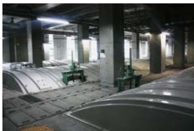
反応槽は覆蓋されている
