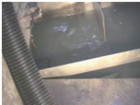
図-4 水面制御装置の稼働状況（手前はガイドウォール。中央に渦流が発生している）
