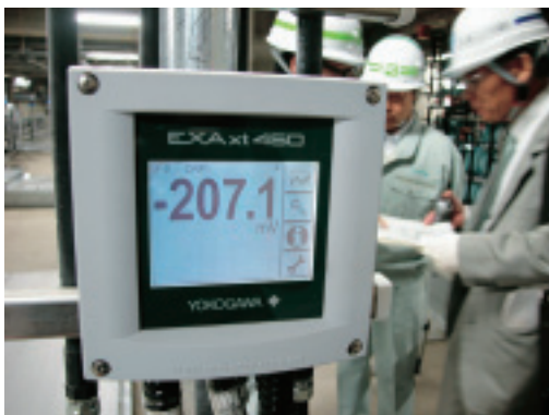
嫌気槽の酸化還元電位は200台前半を維持している
