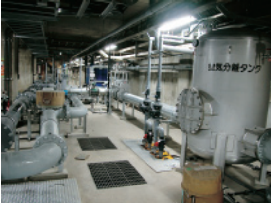
処理水はサイフォン機構によって自然流下でろ過される
