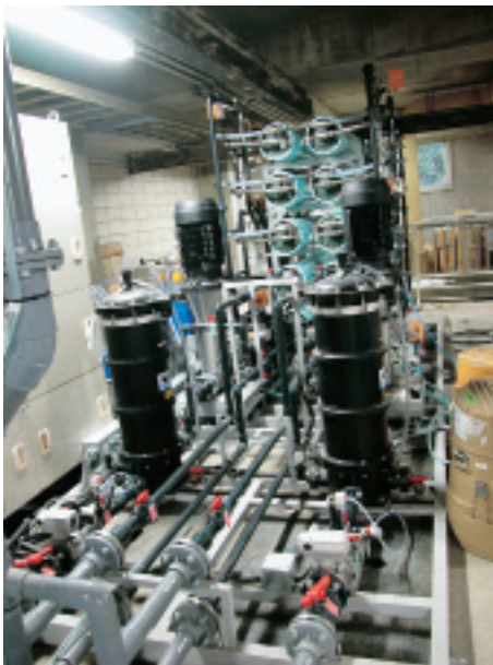
処理水はサイフォン機構によって自然流下でろ過される
