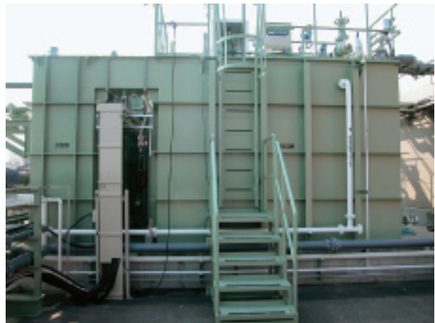
コンパクトな沈殿槽と反応槽(無酸素槽・好気槽)
