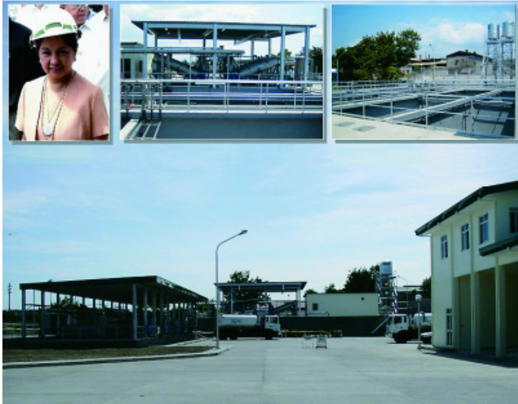
引き渡し済の汚泥処理場と竣工式に出席されたアロヨ大統領（左上）
