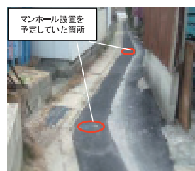
未普及解消技術の例（道路線形に合わせた施工）
