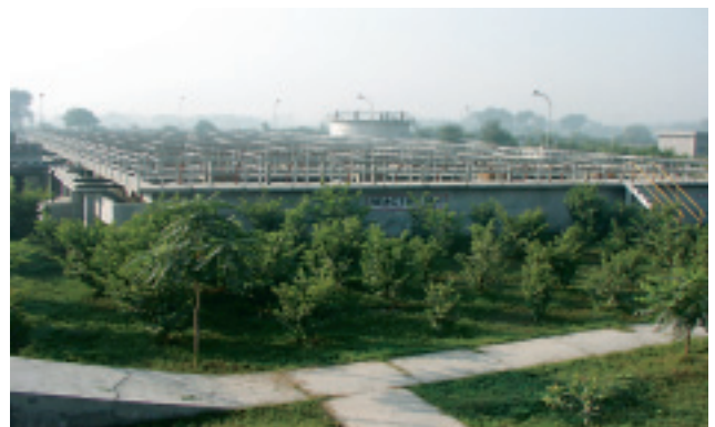
写真-5 下水処理場, カーナル, UASB法, 能力40,000 m 3 /日, 反応槽, 2002年
