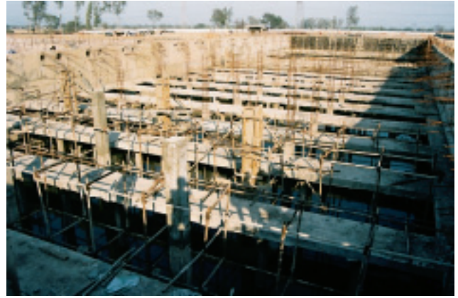
写真-4 下水処理場建設, ファリダバッド, UASB法, 能力45,000m 3 /日, 反応槽, 1997年
