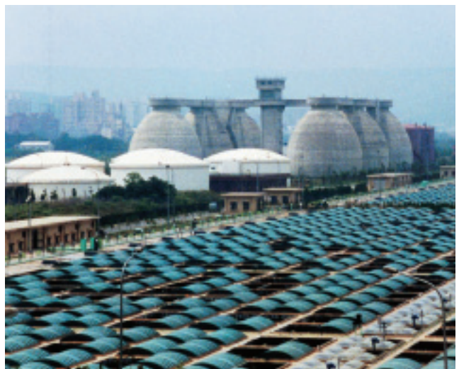
台湾八里下水処理場
