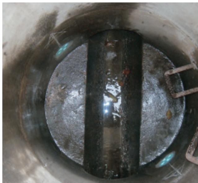
取り付けられた過剰間隙水圧消散弁
