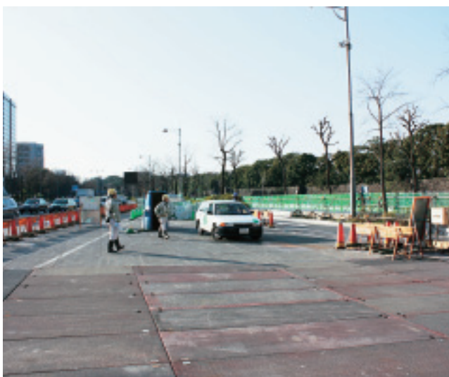
着工当時の調整池（2006年7月）㊤と現在の日比谷交差 点付近。この下に調整池がある
