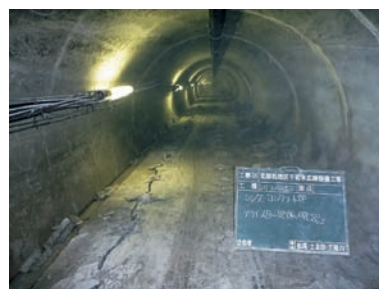
写真-4 シンダーコンの静的破碎
