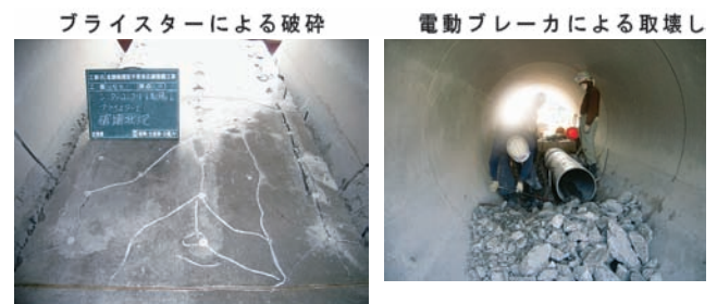
写真－２ シンダーコンの取り壊し状況
