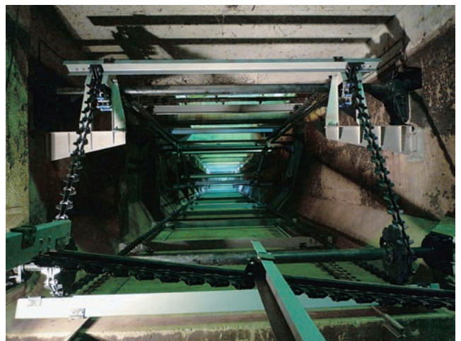
ノッチチェーン式汚泥掻き寄せ機
