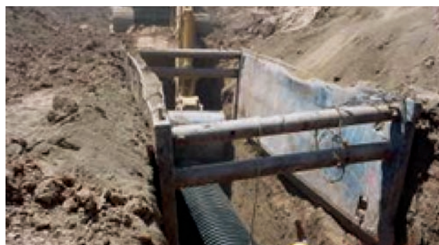
写－2 Mexicali下水管路敷設工事－HDPE 1000mm
