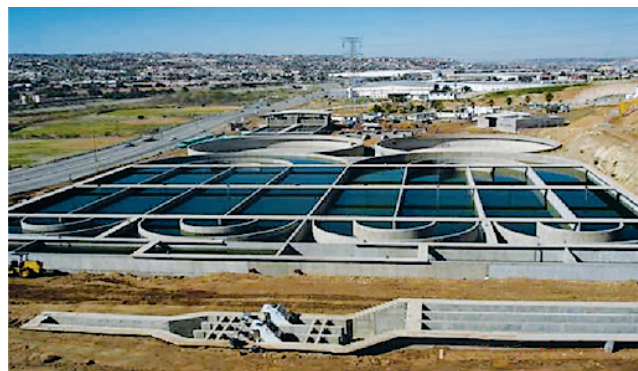
写－1 Tijuana市Los Olivos下水処理場 （オキシデーション・ディッチ法、処理能力4万 \text{m}^3 /日）
