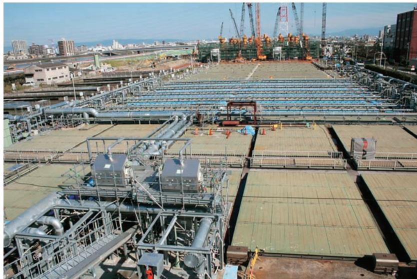
既存の水処理施設を改造しMBRを導入（中央のパイプが見える部分）。その奥には工事中的の大和川ポンプ場が見える
