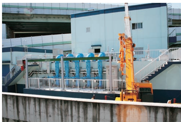
再生水をつくる繊維ろ過棟
