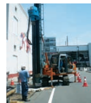
横浜市(アンカーウイング工法)
