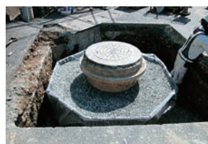
浜松市(マンホールフランジ工法)
