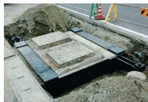
出雲崎町(アンカーウイング工法)
