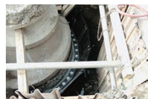
横浜市(マンホールフランジ工法)
