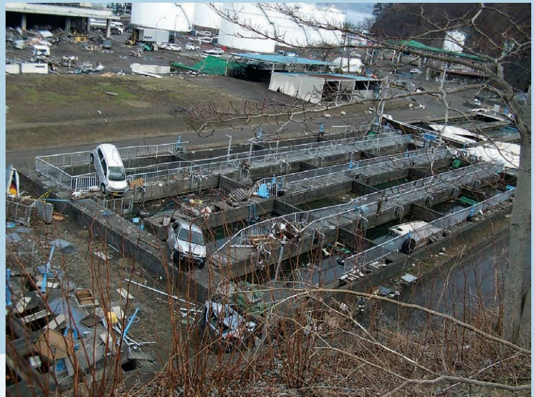
流された車両などの漂流物が施設内に散乱（釜石市・大平浄化センター）
