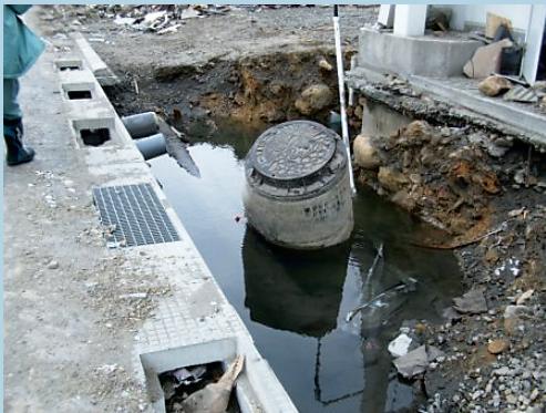
津波で倒壊した建設中のマンホール（大船渡市）
