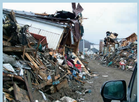
津波で壊滅状態になった市街地（宮古市）
