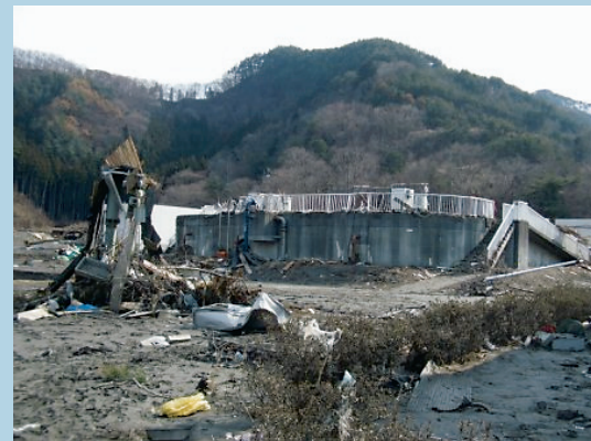
施設全体が津波で破壊された浄化センター（大槌町）
