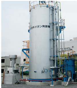
写真-2 消化槽外観
