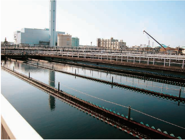
日明浄化センターの水処理施設
