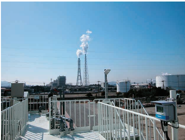
生産水を供給している九州電力(株)の新小倉発電所
