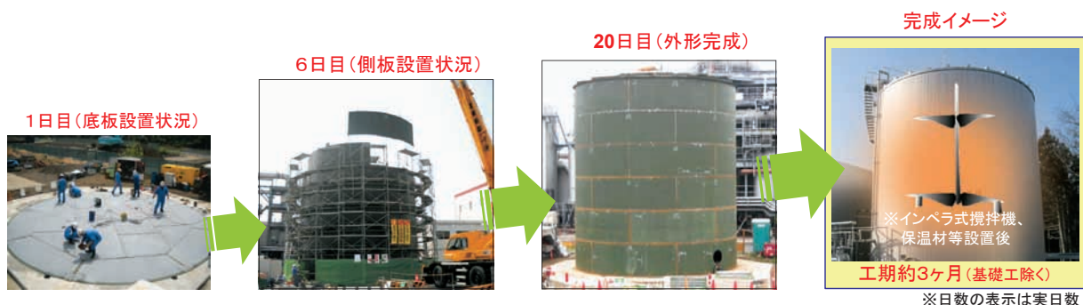
実証実験施設の建設状況
