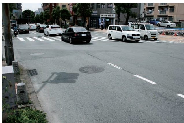
取替工事によって車道に設置された次世代型マンホールふた
