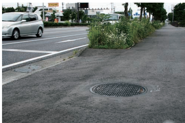
歩道での設置状況
