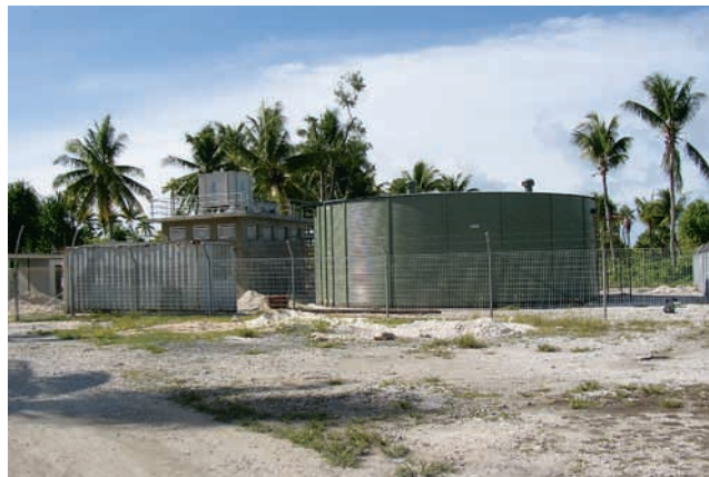
原水曝気装置と曝気後の原水タンク（キリバス）
