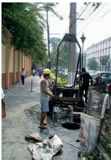
管路内堆積物除去作業（マニラ）
